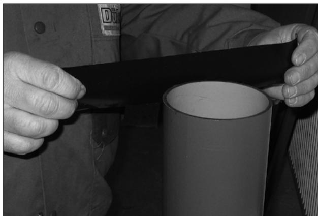
4. Равномерно натянув ленту pro-cut, обернуть ее вокруг трубы, таким образом, чтобы кончики ленты накладывались друг на друга. В случае если концы не достают друг до друга следует отклеить ленту с обеих сторон и натянуть ее сильнее, чтобы концы приклеились внахлест.
