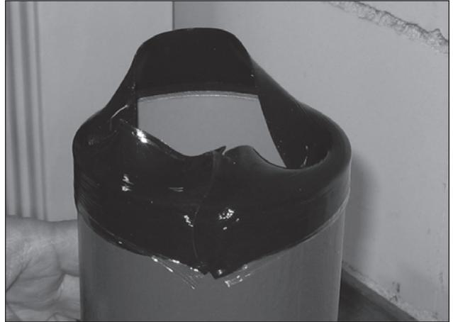
5. Загнуть ленту снаружи и изнутри, прижать ленту к внутренней поверхности трубы.
