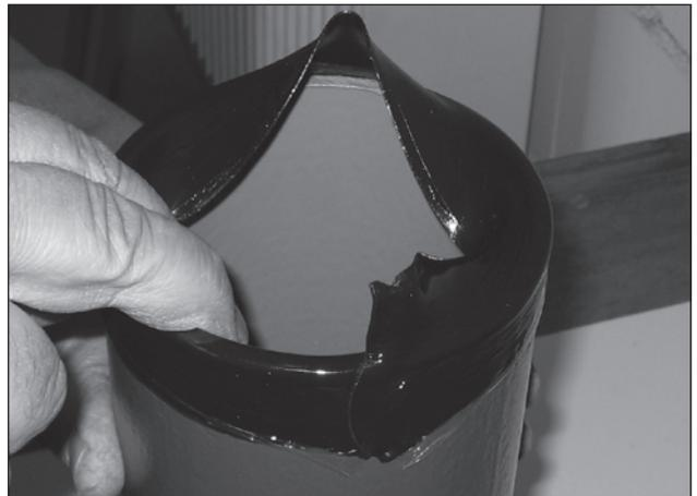
6. Защита обрезанной кромки готова. В случае необходимости перед монтажом соединения следует использовать смазывающее средство
